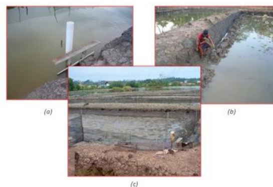
Jambar S. Kontruksi Tambak Budidaya Penggemukan Kepiting Bakau ( Scylla serrata ) a. Saluran pengeluaran (outlet) b. Waring Bawah c. Waring atas
